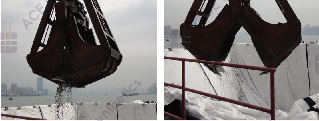
El proceso de llenado debe detenerse cuando la altura de relleno alcanzan la altura diseñado de ACEContainer™.
